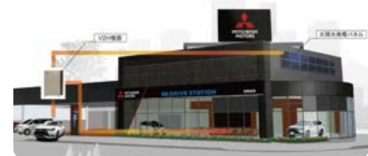
電動DRIVE STATIONには、太陽光発電システムとV2H機器が設置されており、太陽光発電による電動車両への充電と、電動車両の駆動用バッテリーに蓄えた電気を店舗に供給することができます。災害時に停電が発生した際には、電動車両の電力を使用し、携帯電話やPCの充電、フリーWi-Fiがお使いいただけるなど、緊急時の避難場所としてもご活用いただけます。
